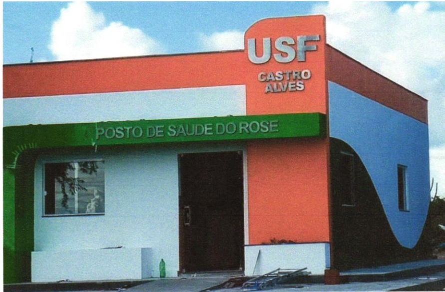
FOTO03 - APLICAÇÃO MANUAL DE PINTURA COM TINTA LÁTEX ACRÍLICA EM PAREDES, DUAS DEMÃOS. AF_06/20140
