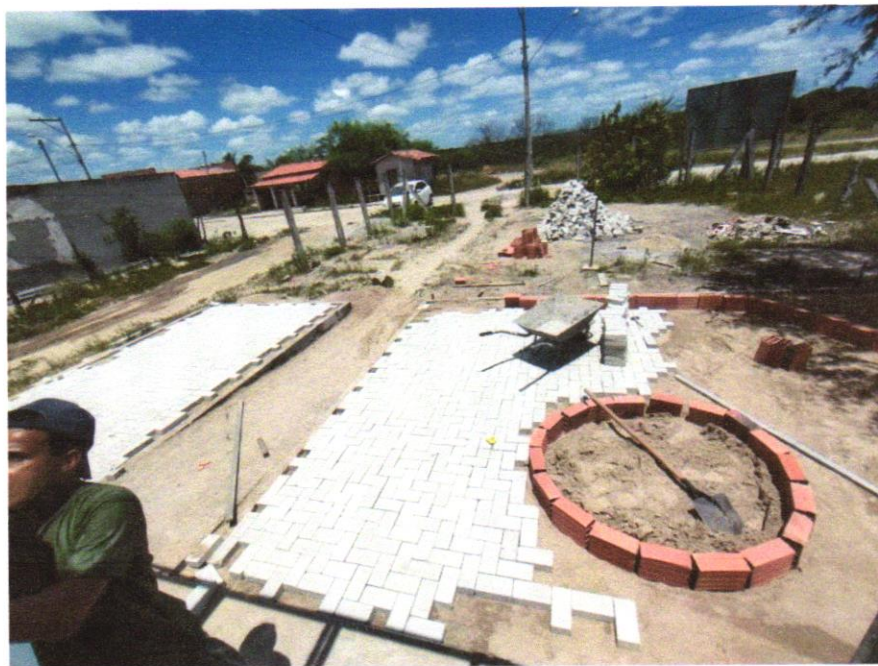
FOTO 06-EXECUÇÃO DE PASSEIO EM PISOINTERTRAVADO
