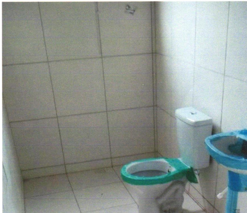
FOTO 30 - REVESTIMENTO CERÂMICO PARA PAREDES INTERNAS COM PLACAS TIPO ESMALTADA EXTRA DE DIMENSÕES 33X45 CM APLICADAS EM AMBIENTES DE ÁREA MAIOR QUE 5 M 2 A MEIA ALTURA DAS PAREDES. AF_06/2014
