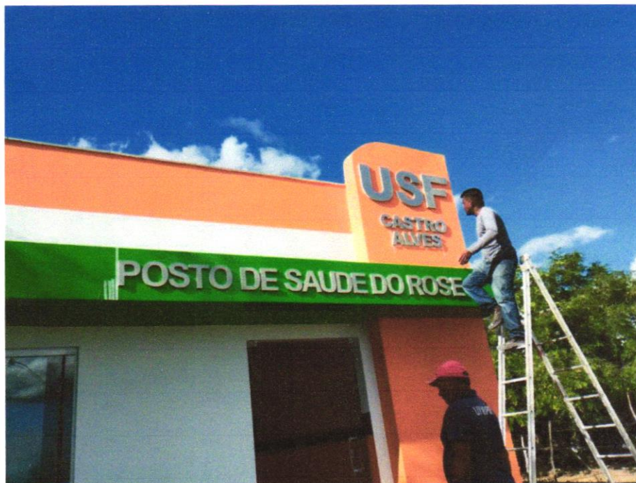
FOTO 09- LETRAS EM ALUMINIO 15 X 15 CM -INSTALADO
