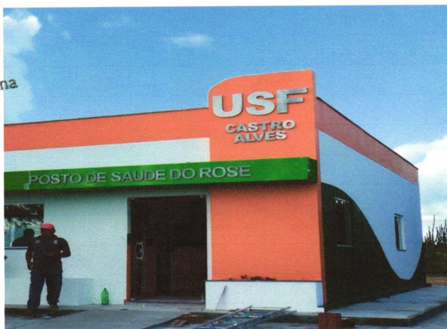
FOTO 10- LETRAS EM ALUMINIO 20 X 20 CM -INSTALADO
