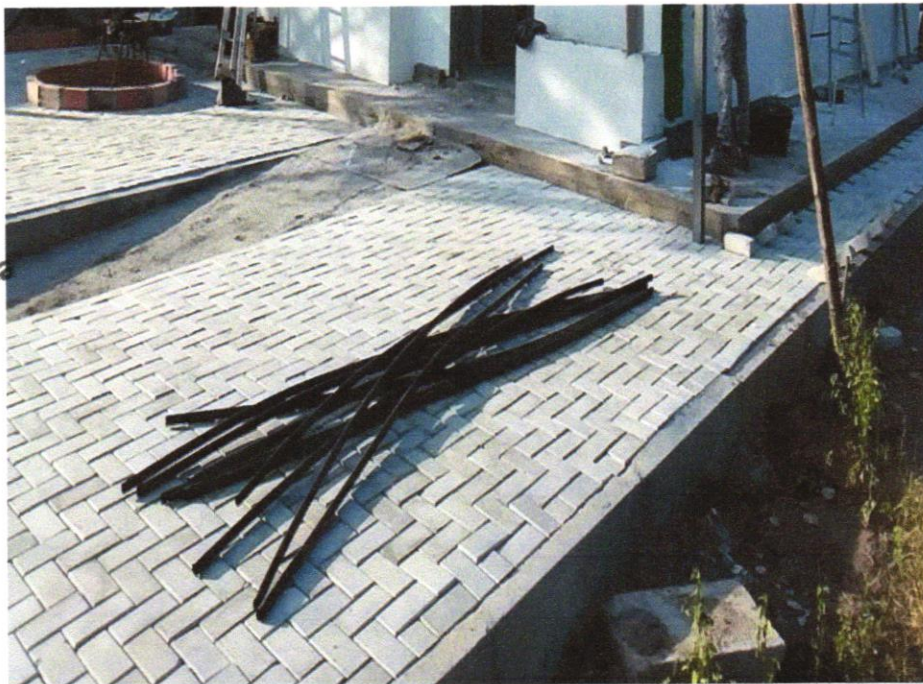
FOTO 04-EXECUÇÃO DE PASSEIO EM PISOINTERTRAVADO
