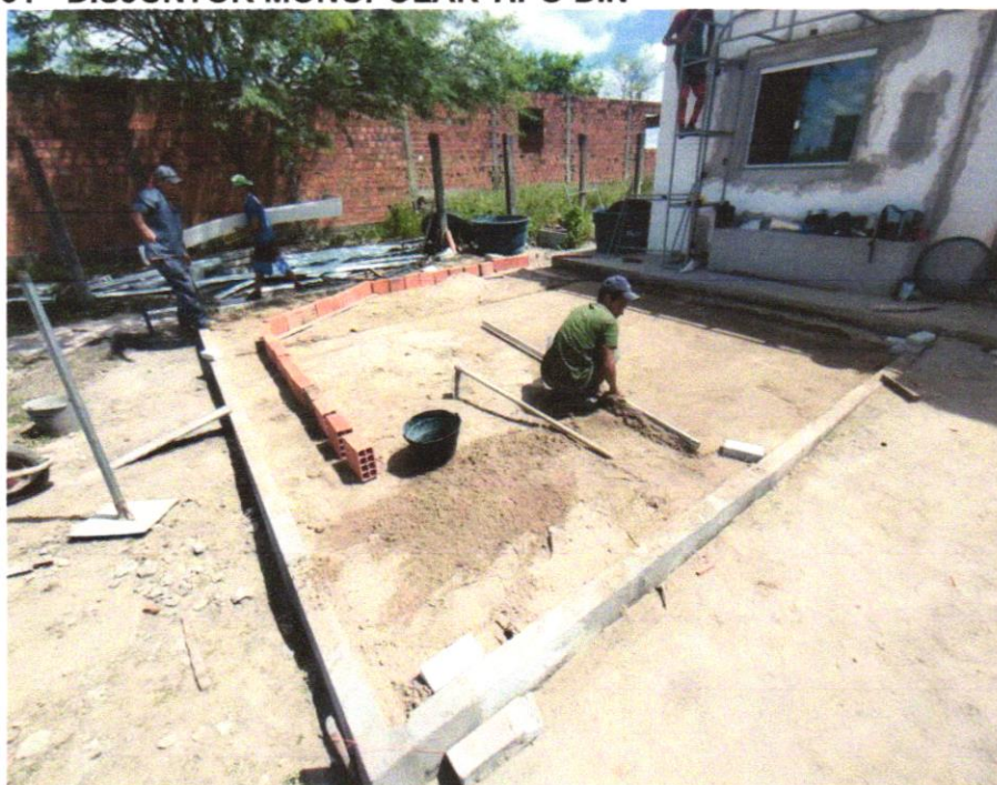
FOTO 32 – Assentamento de Guia meio Fio
