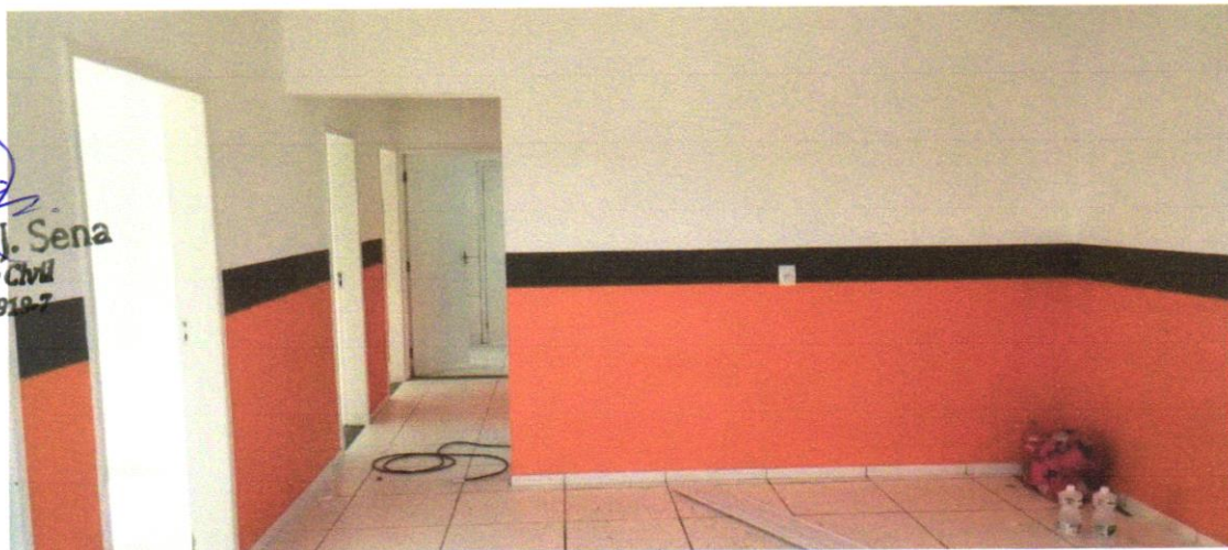
FOTO 14 – RODAPÉ CERÂMICO DE 7CM DE ALTURA COM PLACAS TIPO ESMALTADA EXTRA DE DIMENSÕES 45X45CM. AF_06/2014
